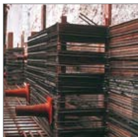
Reprise de bétonnage Concrete joint
