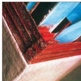
Enrobage structure métal Metal structure encasement
